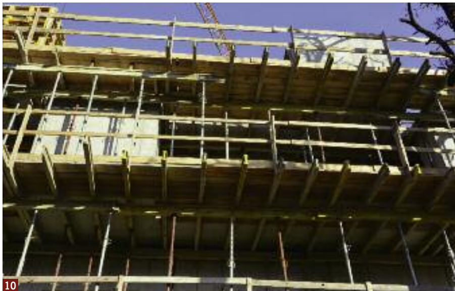
Elementy deskowań i podestów wykonane z drewna
