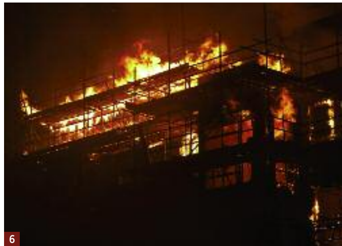
Pożar w trakcie budowy budynku w technologii szkieletu drewnianego
