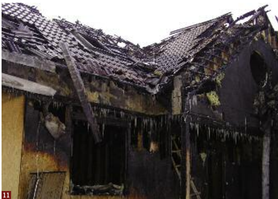
Zniszczenia spowodowane pożarem podczas budowy domu wykonanego w technologii szkieletu drewnianego (fot. T. Wiśniewski)
