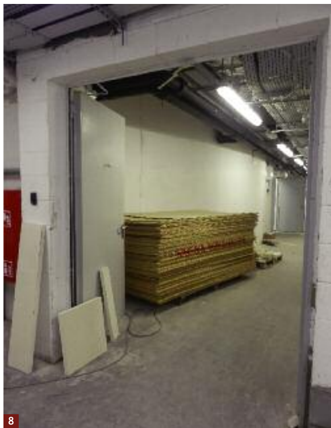
Palne materiały budowlane składowane w obrębie dróg komunikacji (ewakuacji)
